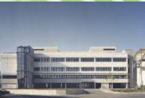
Nordseite mit Liegendkrankenvorfahrt
