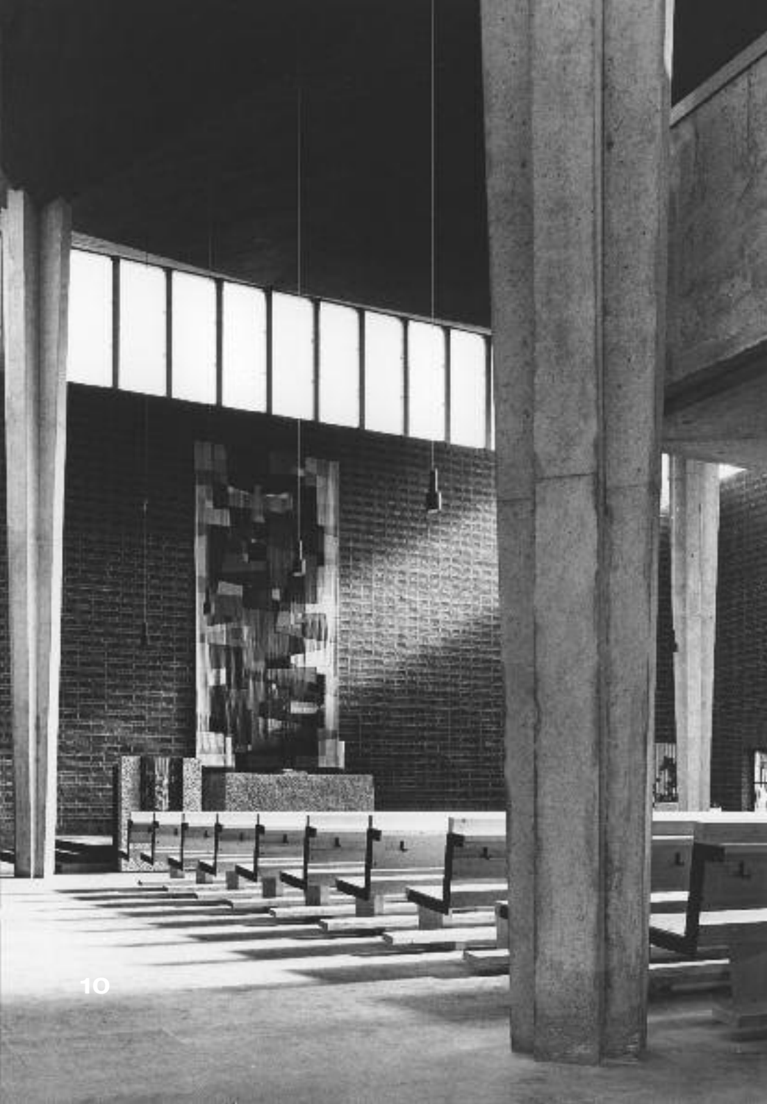
Filigrane Betonstützen tragen die Dachkonstruktion
